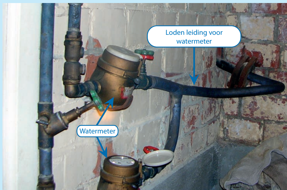
figuur 3: Loden leiding voor watermeter
