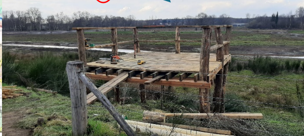
Afgraving van zandstort De Hellekens en hermeandering
